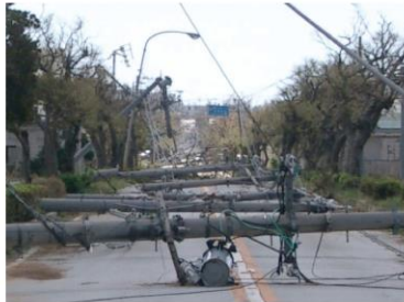
図-1 被災した配電用電柱
