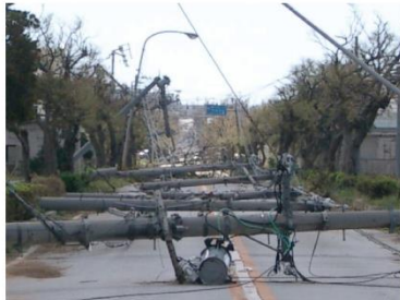
図-1 被災した配電用電柱
