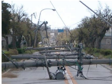
図-1 被災した配電用電柱
